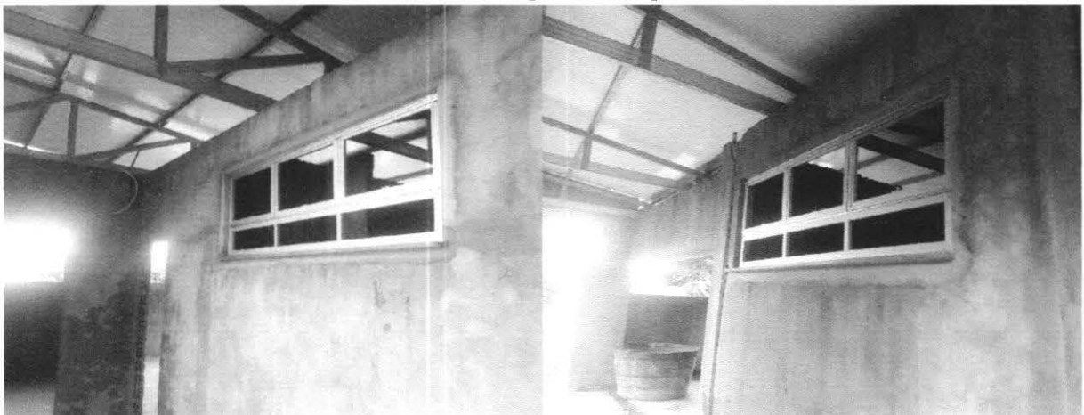
Esquadrias pintadas com vidro instalado
