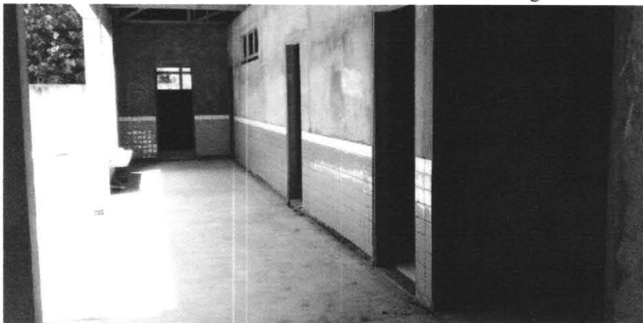
Fachada com revestimento cerâmico instalado
