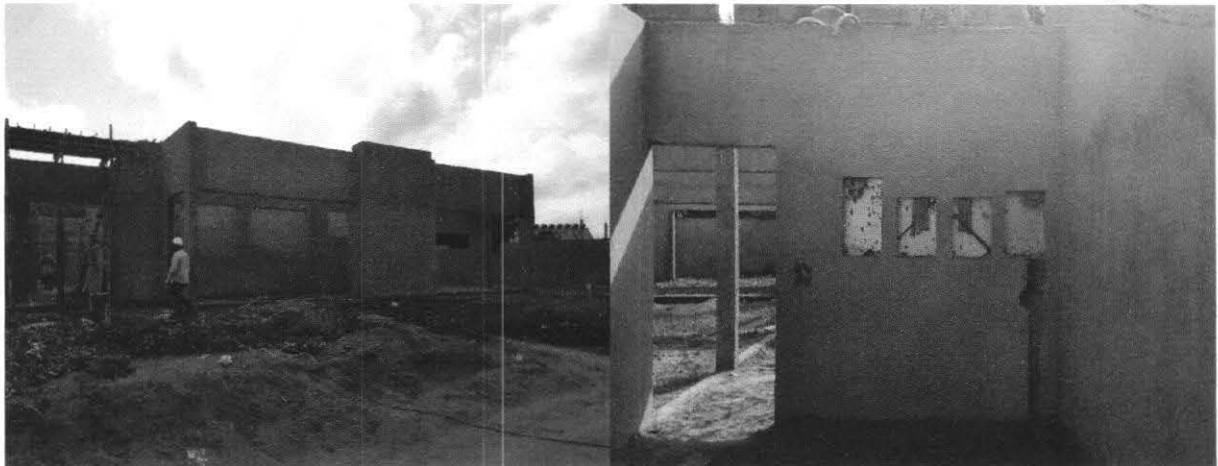
Viga de ferro em execução e esperas para instalação de quadros elétricos
