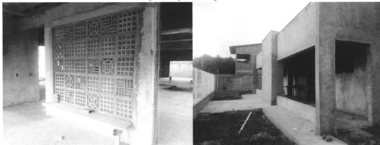
Fechamento em cobogó, calçada passeio, alvenaria rebocada e vergalhões de SPDA
