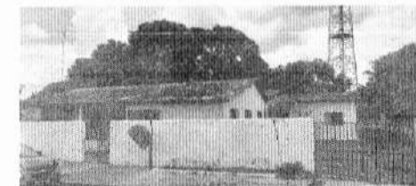
FACHADA EXISTENTE Levantamento fotográfico
